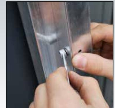
Am besten Sie verbinden erst ein Seitenelement mit einem Frontelement über Eck und verschrauben es mit dem Boden.
